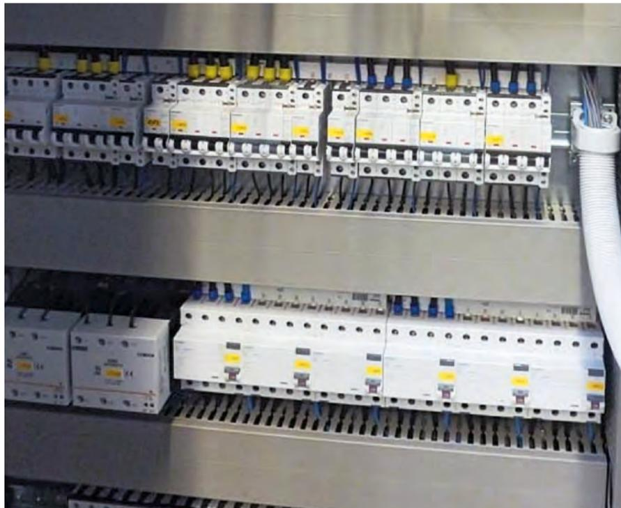
Leicht zugängliche Sicherungsbauteile der Stromversorgung
